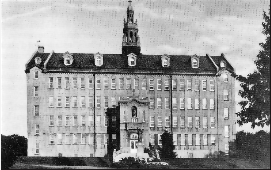
Photo 1. L'édifice abritant le Juvénat Saint-Gabriel, de 1925 à 1972
