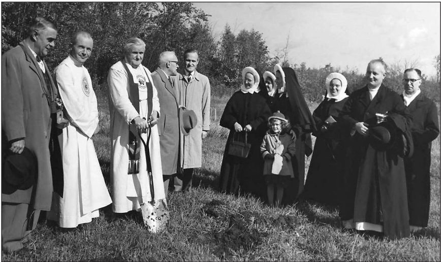
Photo 1 : Première pelletée de terre de la construction du Pensionnat c.1954. Fonds Pensionnat des Sacrés-Cœurs.
